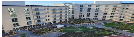
Barkaby Kv 11 / Apartmentgebäude
